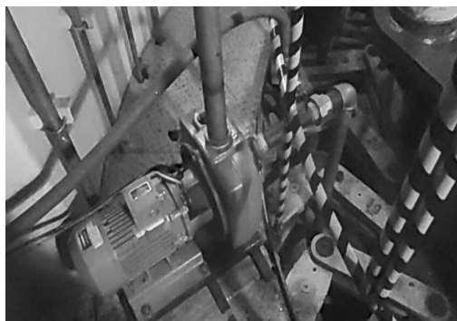
Figura 4. Motobombas que extraen el exceso de agua. Fuente: Tomada en central hidroeléctrica Alto Anchicayá. Autores.
